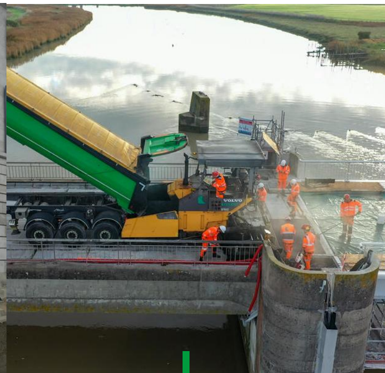
Réfection de voirie Le Pont du Brault
