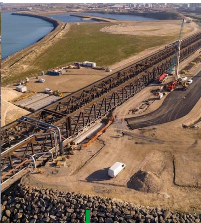
Démantèlement partiel Viaduc Mole d'Escale La Rochelle
