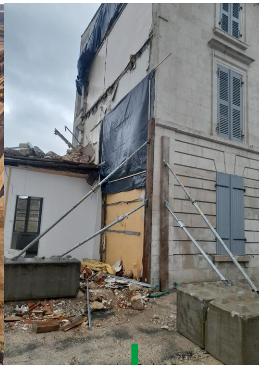
Intervention d'urgence Mise en sécurité
