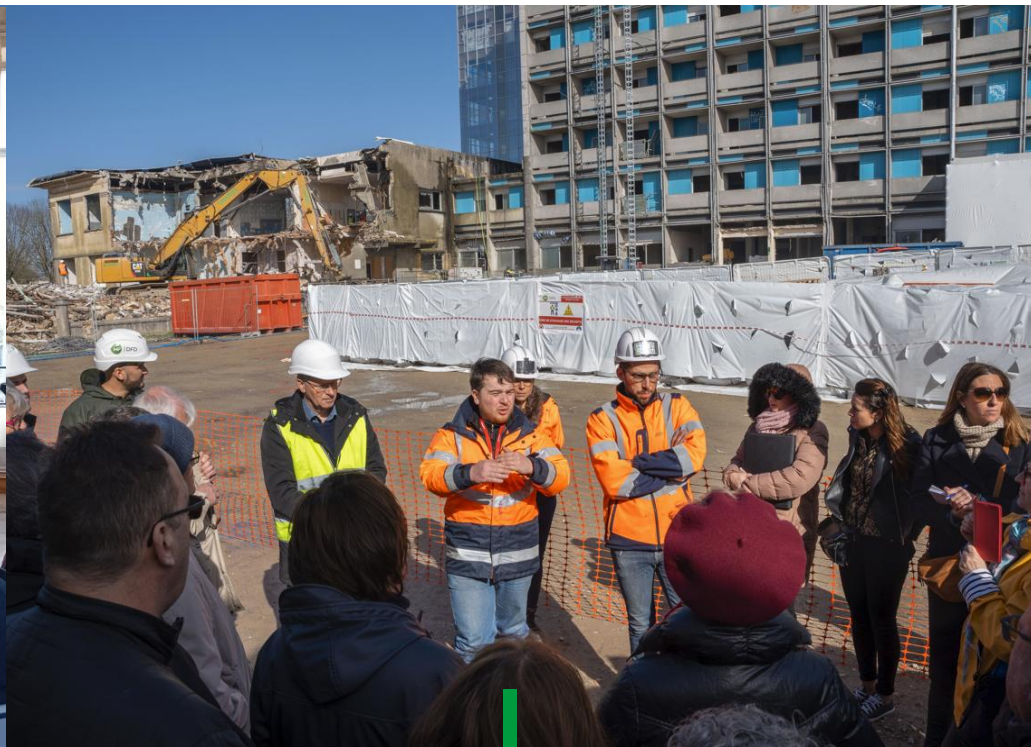
Adopte ton chantier Accueil et rencontre avec les riverains
