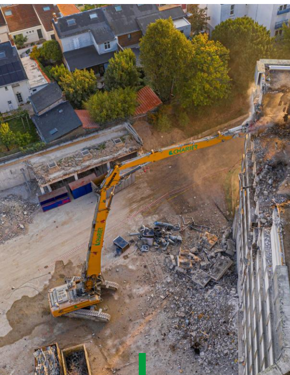
Déconstruction Hôpital Rochefort
