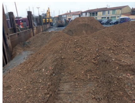
Béton recyclé utilisé comme matériau de remblai.
