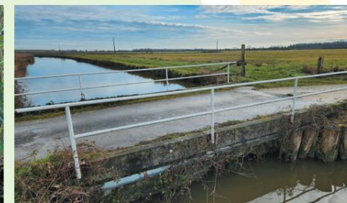
**Pont mixte dalle béton / voûte maçonnée**
