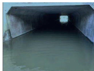
Vue de l'ouvrage constitué de cadres béton armé préfabriqués (environ 80 cm d'eau le jour de la visite).
