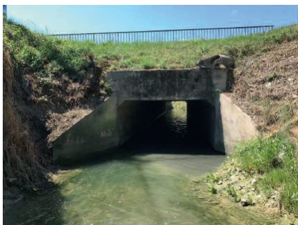
Vue globale de l'ouvrage depuis le canal en amont. Murs en aile. Murs béton armé en tête des cadres aux extrémités de l'ouvrage retenant les remblais sus-jacents.
