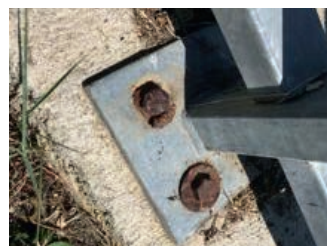
Vue des ancrages de garde-corps en état de corrosion avancé.
