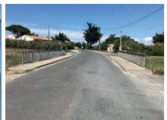
Vue de la voirie sus-jacente en enrobé, des trottoirs béton et garde-corps métallique S8.
