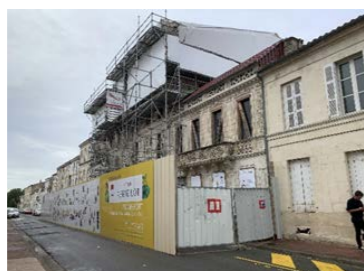
Maison Pierre LOTI Ville de Rochefort rénovation de la maison en vue de sa réouverture
