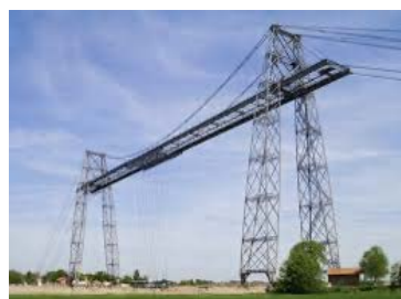
Pont Transbordeur / Communauté d'Agglomération Rochefort Océan Aménagement des abords
